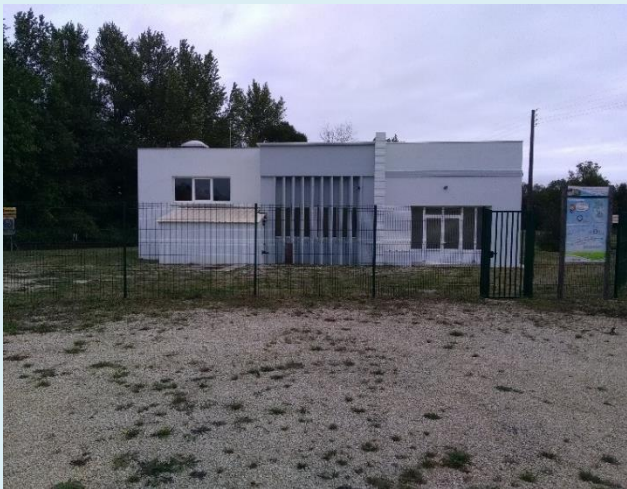
N°1 Entrée du PPI et vue de la station de traitement
