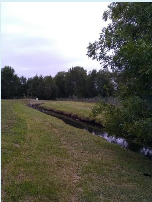
N°4 Canal exutoire de la source de Moulin Neuf
