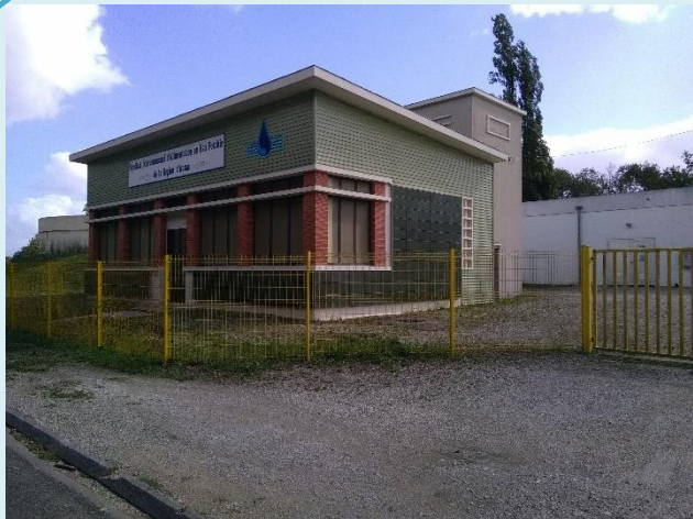
N°1 Entrée du PPI et vue de la station de traitement
