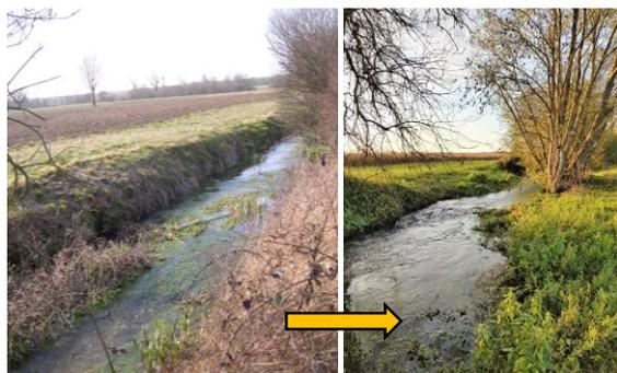
Travaux d'aménagement du Crachon (affluent de l'Auge) avec pour objectif de restaurer une diversité des milieux aquatiques par retalutage de berges en pente douce, en créant des alternances de méandres, radiers, fosses et en remontant la ligne d'eau. Le second objectif était l'aménagement de la confluence entre le Crachon et l'Auge pour améliorer la connexion piscicole.
