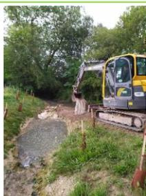
Ajustement de travaux de 2019 sur le Crachon (réglage de hauteurs de radiers pour fonctionnalité vis-à-vis de la continuité piscicole).
