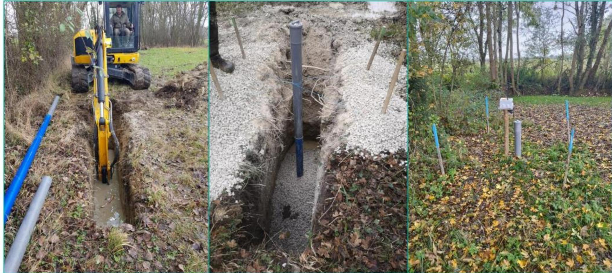
*Creusement du trou à l'aide de la pelle mécanique*
