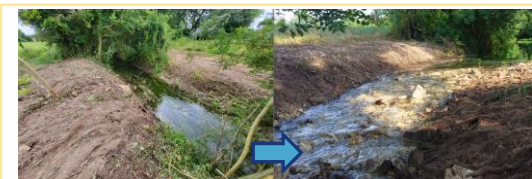
Recharge granulométrique par radiers sur l'amont de la Couture (Couture d'Argenson)
